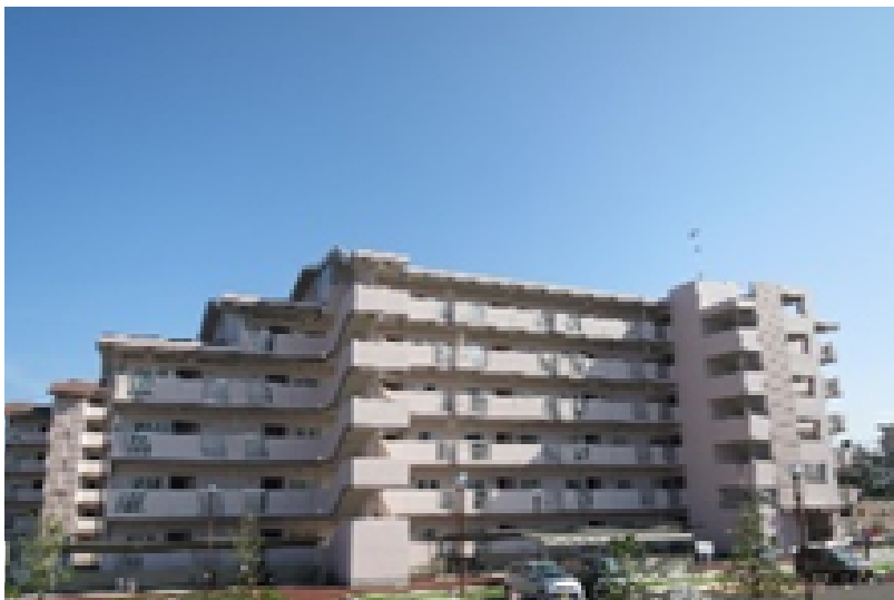
県営 小島住宅
