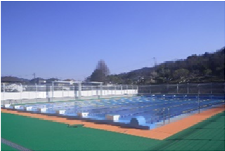
岡崎市立東海中学校プール
