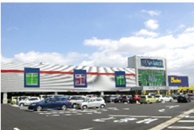
ヤマダ電機 安城店
