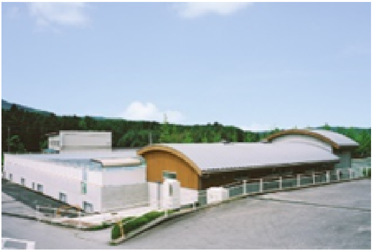
岡崎市立豊富小学校 プール
