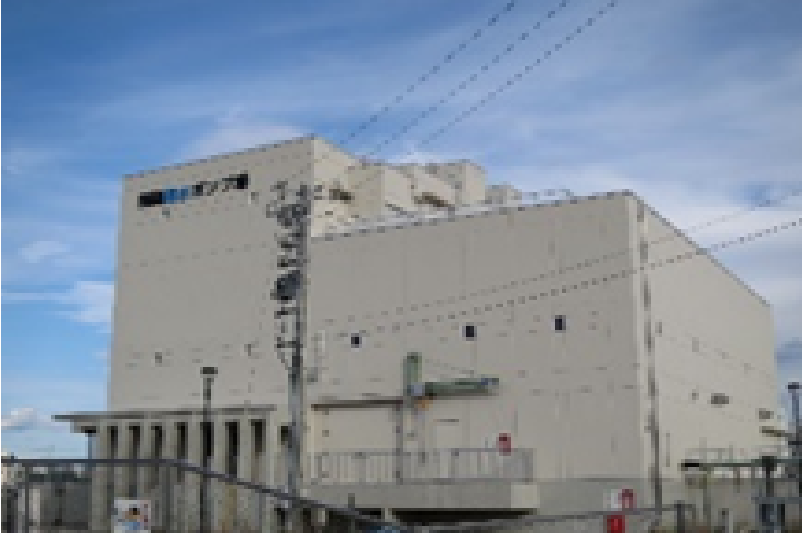
福岡雨水ポンプ場
