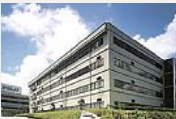
富士機械製造(株) 岡崎工場
