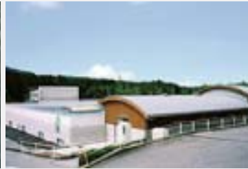
岡崎市立 豊富小学校 プール
